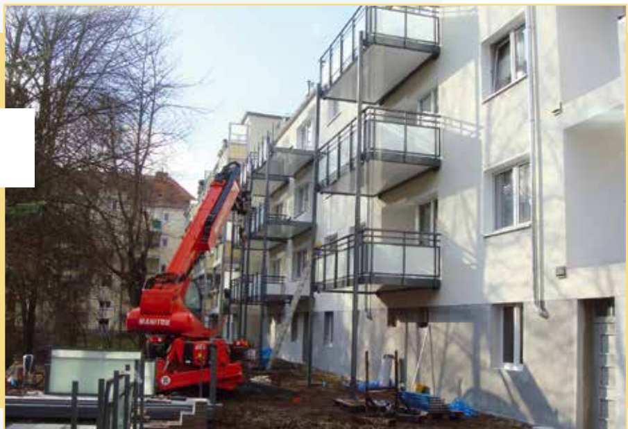
Sanierung Hellenthaler Straße
