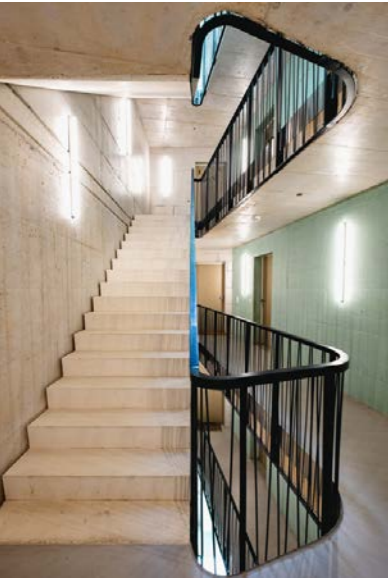
Treppenhaus Palanter Str. 38
